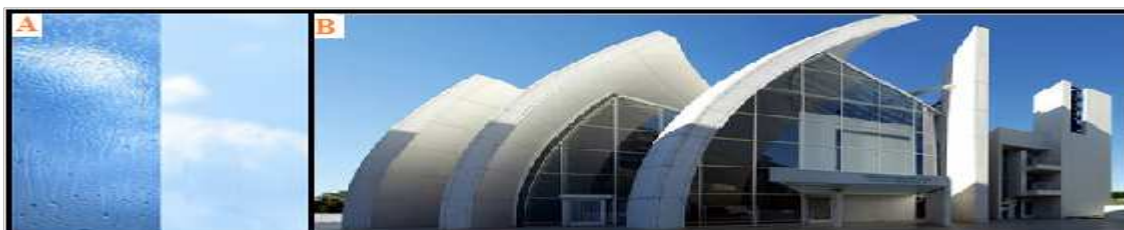
Figura 1-A) Comparação entre vidros normais e com a capacidade de autolimpeza e anti-embaciamento. B) Igreja Dives in Misericordia em Roma construída com betão fotocatalítico (fotógrafo: Liao, 2006)
