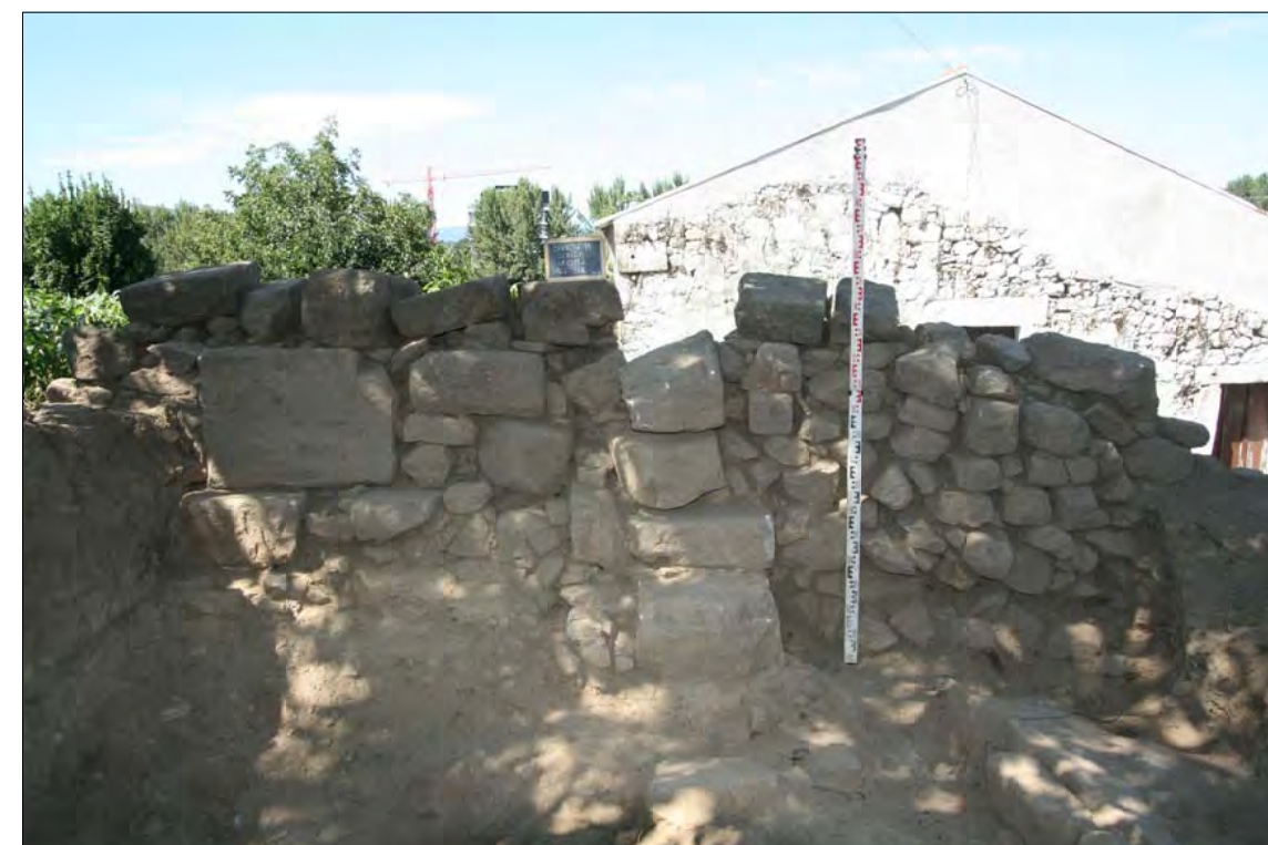
IMG_1295 - Aspeto geral do alçado sul (S/N).
