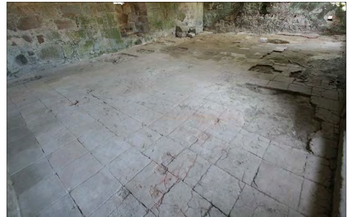
IMG_2535 - Aspeto geral do pavimento UE0403 (SE/NO).
