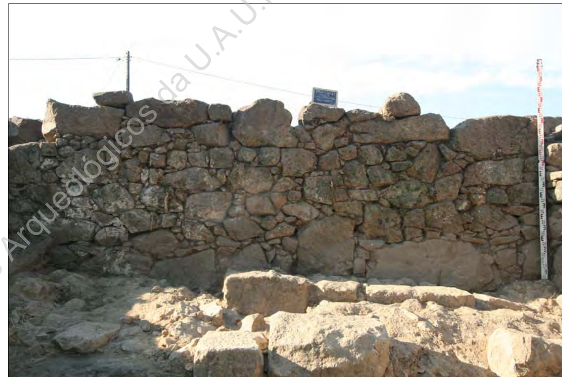
IMG_0680 - Perspetiva geral do alçado norte - UEs 0015 e 0016 (N/S).
