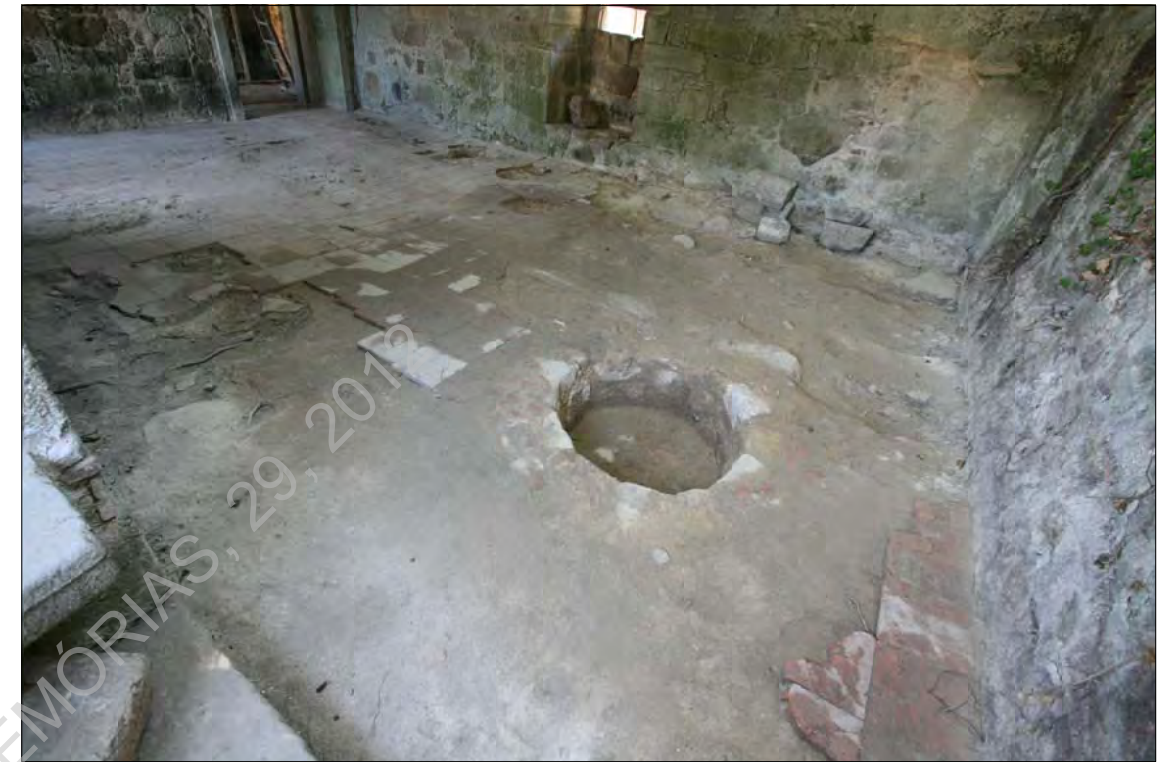
IMG_2538 - Aspeto geral do pavimento UE0403 (NE/SO).
