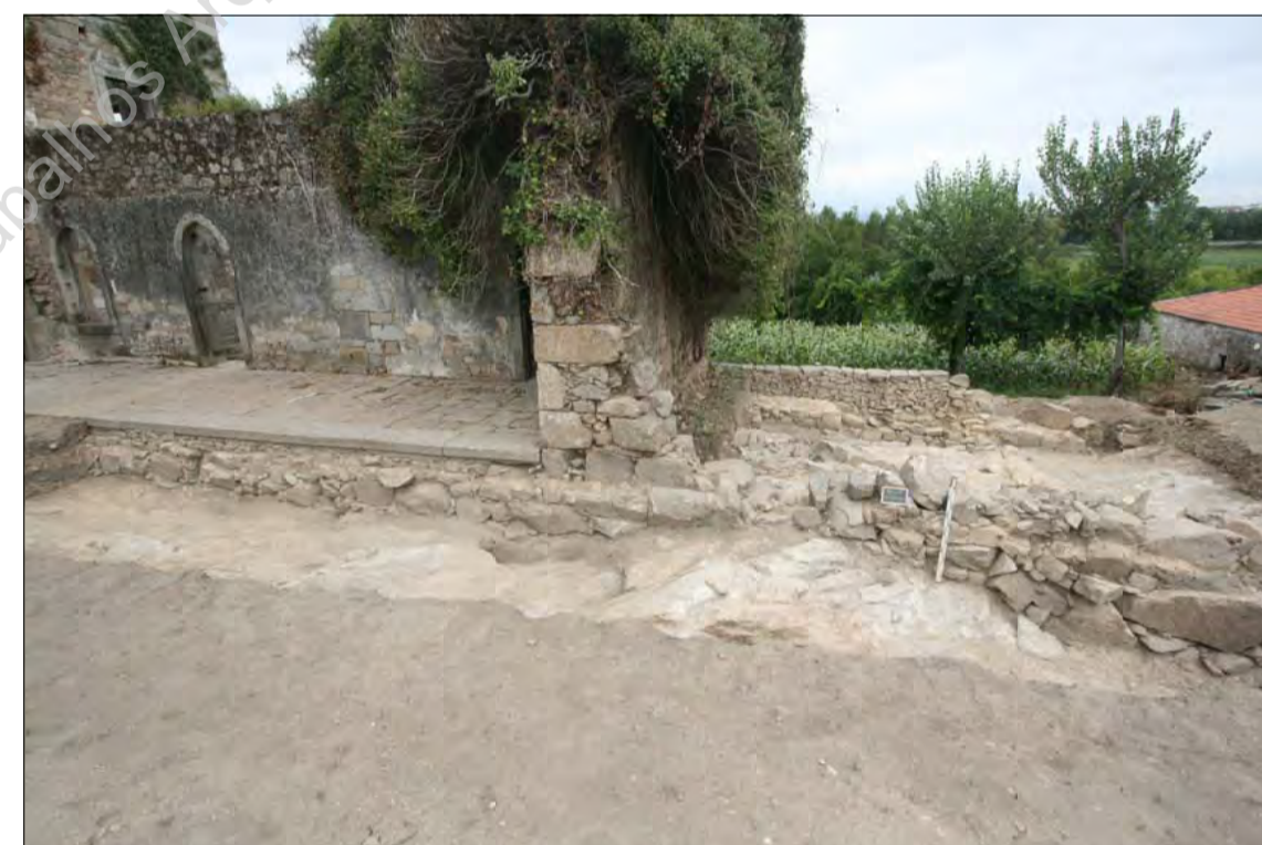
IMG_1935 - Aspeto geral do alçado sul - UEs 0013 e 0014 (SE/NO).
