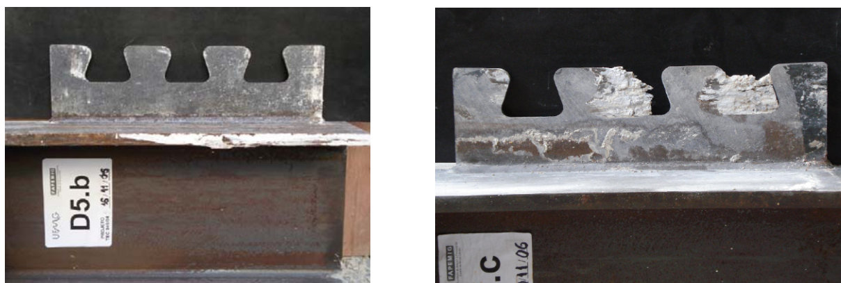
Figura 10 – Aspecto do conector após o ensaio (praticamente intacto) e o efeito de pino.
