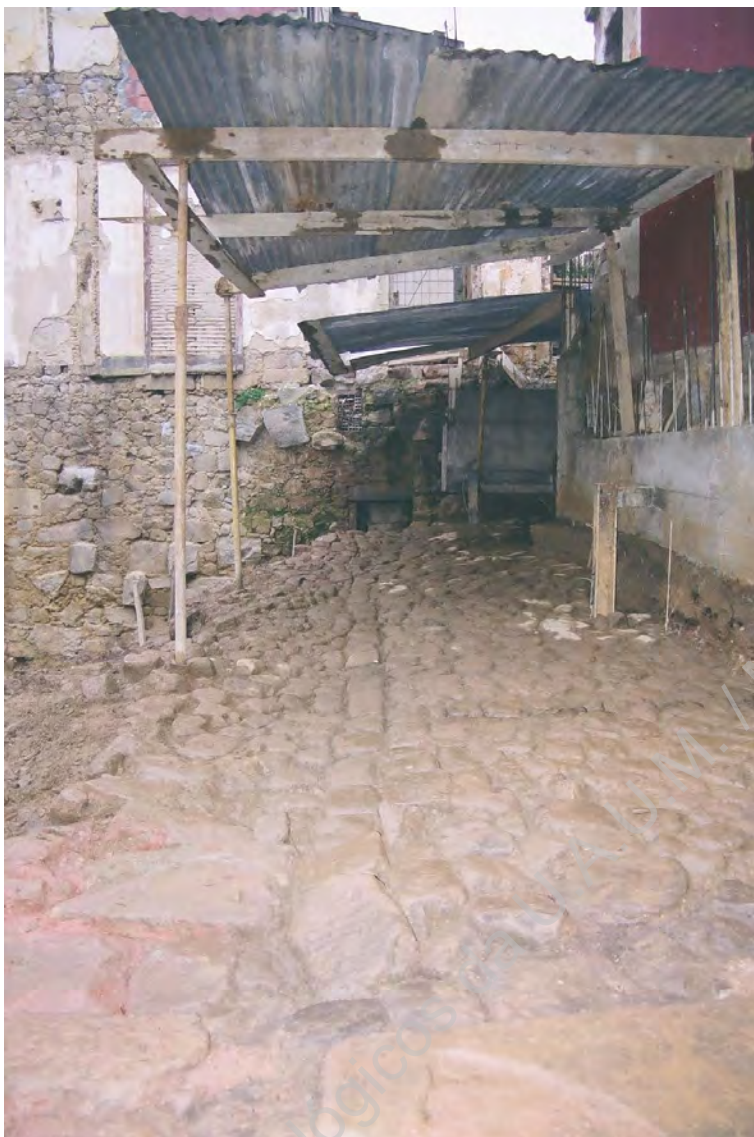
Perspectiva geral da calçada (UE 025) vista de Oeste, antes da implantação das sondagens 7, 8 e 9.
