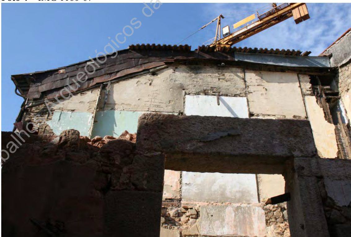
Aspecto da parede divisória do edifício Este-Oeste vista de Sul.
