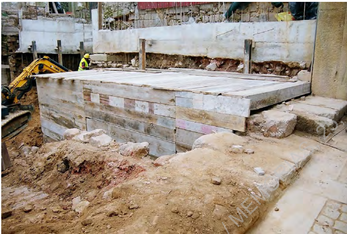
Aspecto final da caixa em madeira para protecção do muro (UE 153)
