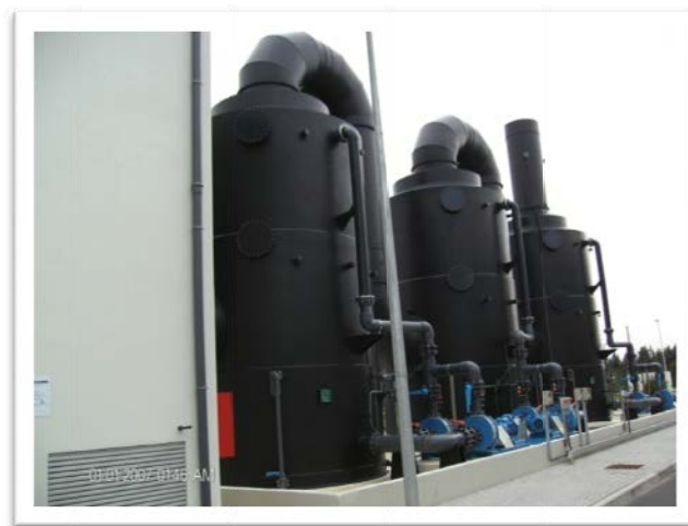
Figura 4.18 – Ventiladores de desodorização
