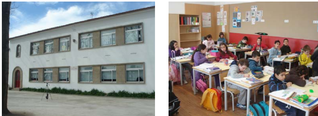
a) b) Figura 2 Medições in situ : a) no exterior; b) no interior
