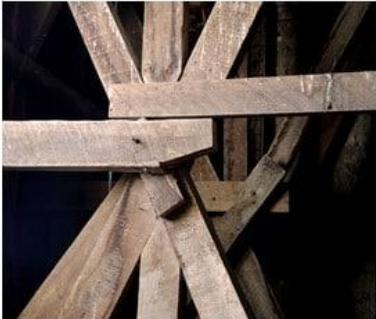
Dentro de estas operaciones está la reconstrucción de las torres laterales en madera, el mejoramiento de todas las conexiones entre macroelementos y la reconstrucción de porciones en quincha, replicando la técnica histórica presente en las partes superiores del edificio.
