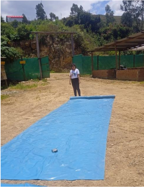
Figura A1. Uso de plástico para impermeabilizar la zona
