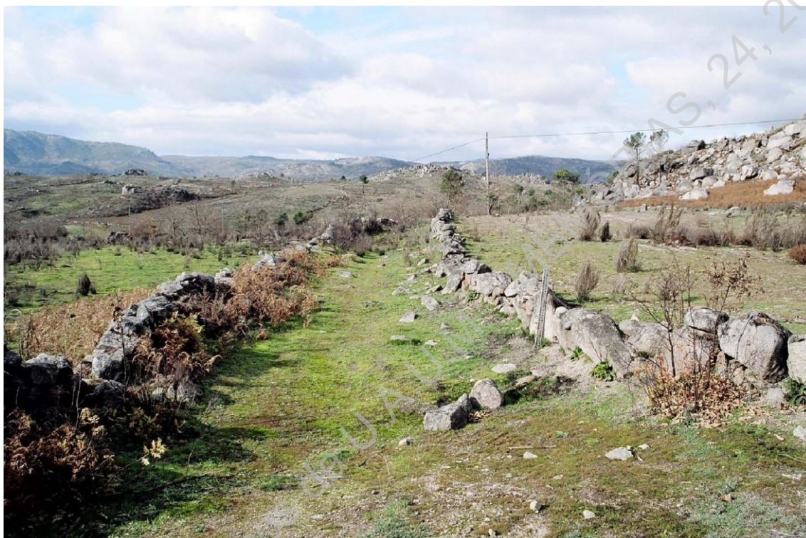
Foto 11 – Perspectiva do troço de via na zona do Fragão do Fôjo, junto ao limite concelhio
