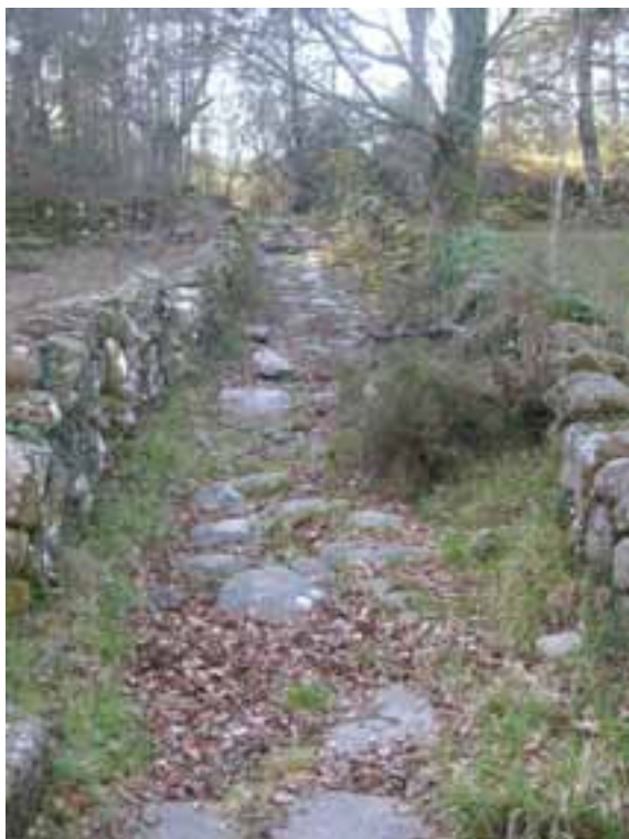
Foto 23 – Troço da via antiga Braga - Chaves junto ao pontão de Corga de Mendo
