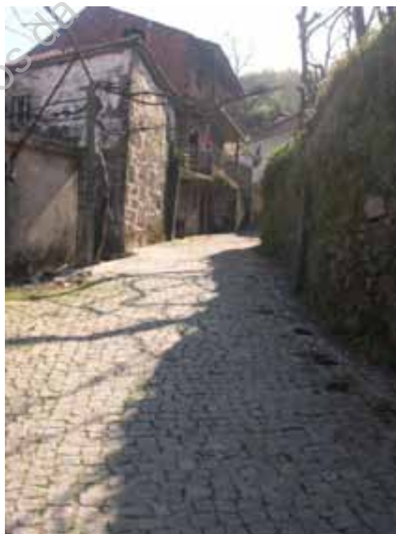
Foto 20 – Troço da via antiga Braga - Chaves na Aldeia
