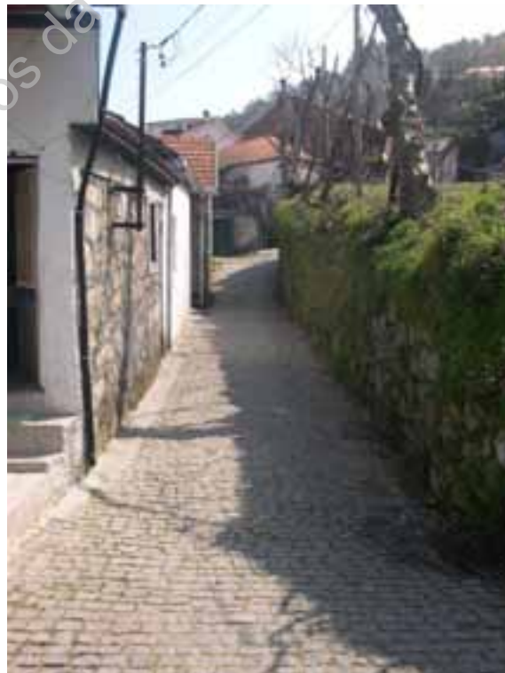
Foto 18 – Troço da via antiga Braga - Chaves na Aldeia
