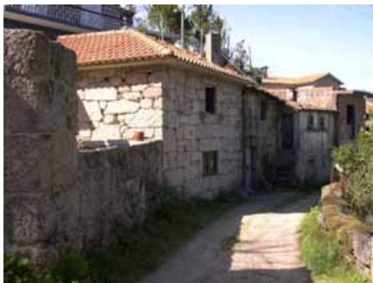
Foto 10 – Casas antigas situadas junto da via antiga Braga - Chaves, no Sudro
