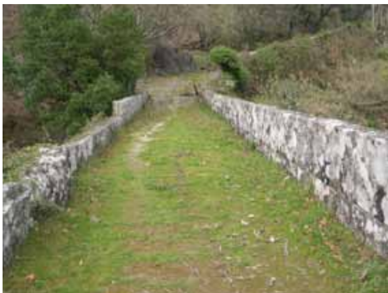
Foto 25 – Tabuleiro da Ponte de Rês, sobre a Ribeira do Saltadouro
