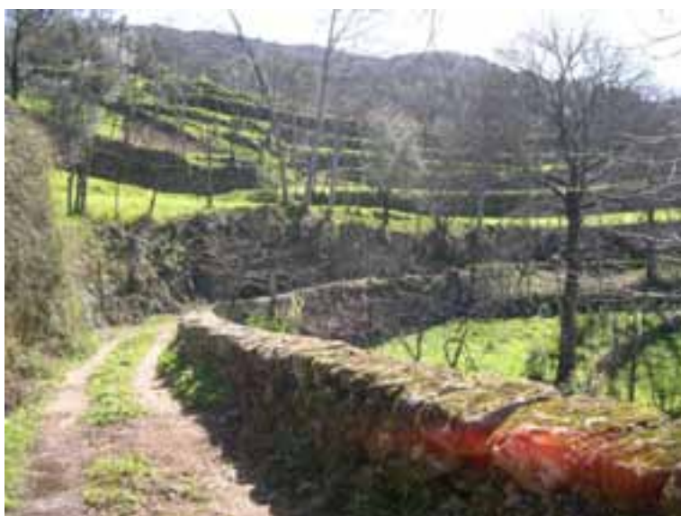
Foto 15 – Troço da via antiga Braga - Chaves no Sudro
