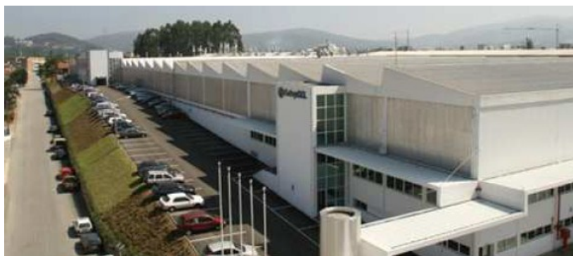
Figura 9 - Instalações da Colep em Vale de Cambra, Portugal ( www.Colep.com )
