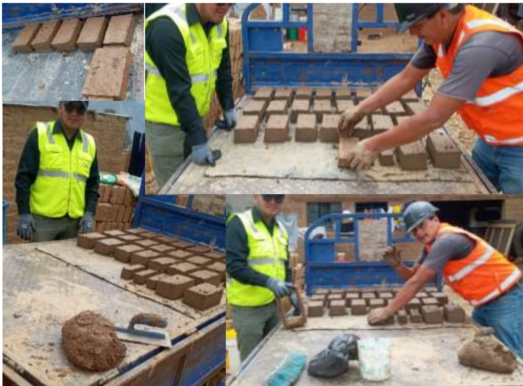
Figura 55. Apilado de adobes frescos Fuente: Propia
