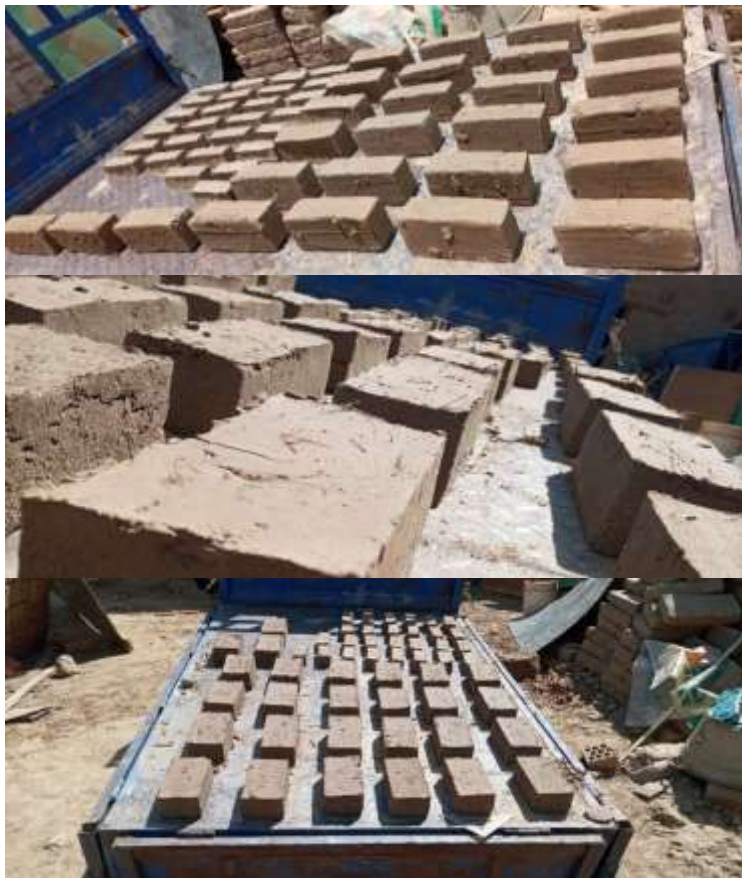
Figura 57. Secado de adobe de canto Fuente: Propia
