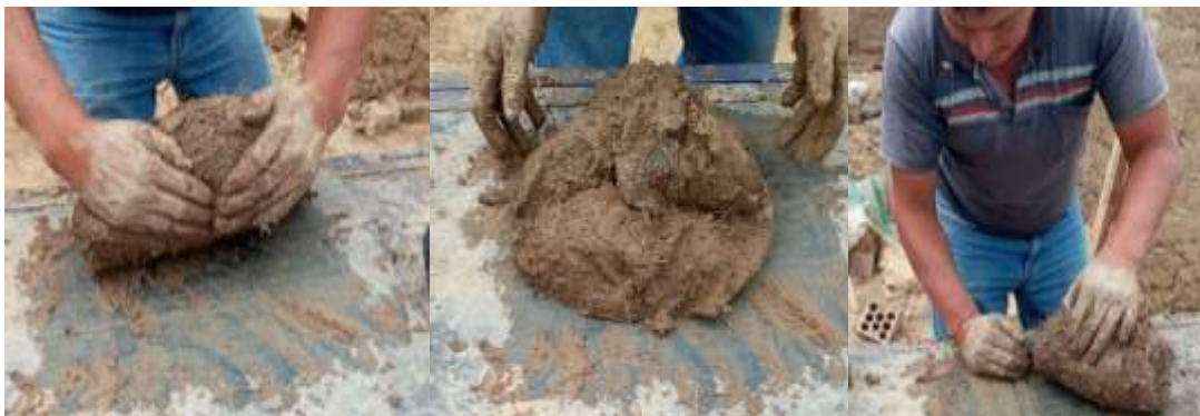
Figura 53. Adición de fibras a la masa plástica de tierra. Fuente: Propia
