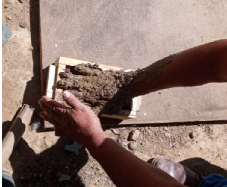
Figura 54. Moldeado del adobe Fuente: Propia
