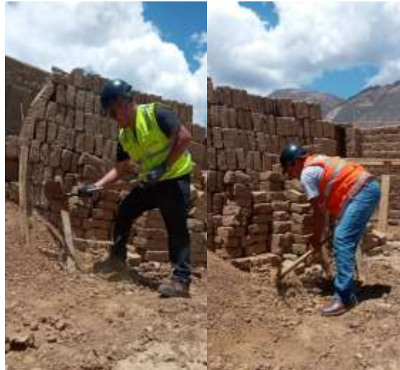
Figura 45. Zarandeado de la tierra Fuente: Propia
