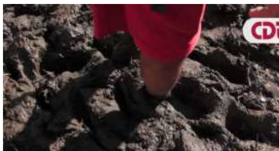
Figura 18. Mezclado de la tierra. Fuente: Corporación de desarrollo tecnológico.
