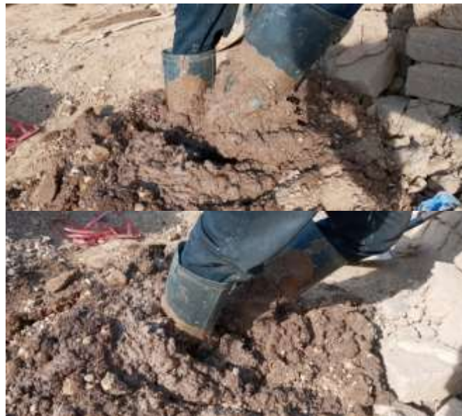
Figura 48. Amasado de la tierra húmeda (estado plástico) Fuente: Propia
