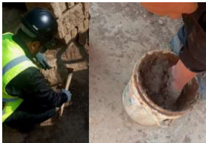
Figura 33. Extracción y reposo de la tierra Fuente: Propia
