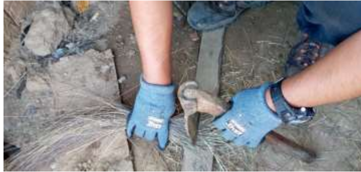
Figura 49. Corte de la paja con azuela Fuente: Propia
