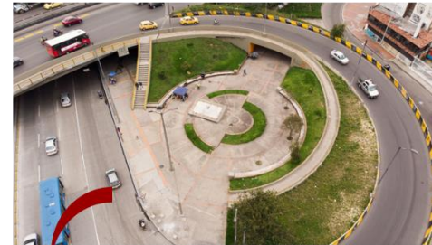
Antes de la intervención
