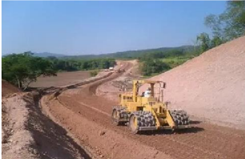
Figura 12 Movimiento de Tierra en subrasante
