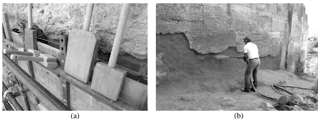
Figura 13 – Técnicas de restauro para erosão basal [23]: (a) técnica tradicional; (b) terra projectada.
