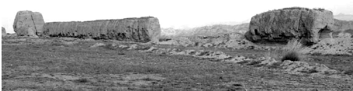
Figura 1 – Secção em taipa da Grande Muralha da China na província de Ningxia [5].
