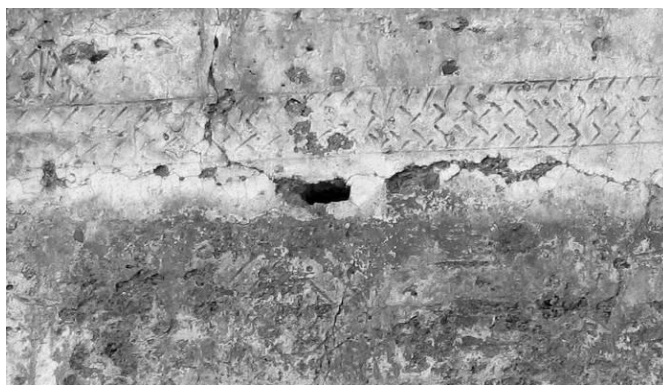
Figura 3 – Acabamento de uma parede em taipa calicastrada [10].
