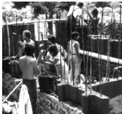
Figura 8 – Reforço de uma parede em taipa através da introdução de canas de bambo [19].
