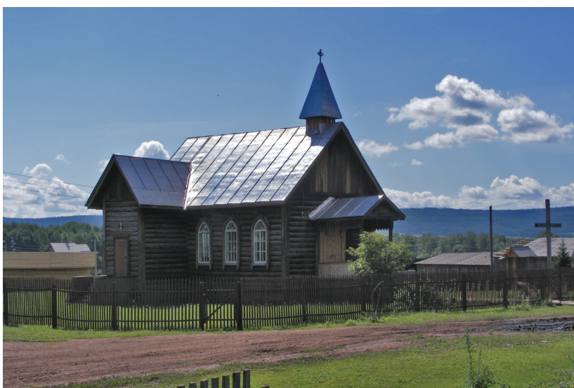
Fot. 16. Kościół w Wierszynie (fot. M. Głuszkowski).
