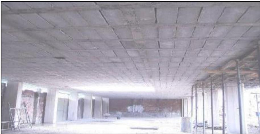
*Nota.* Vista inferior de losa de gran distancia entre columnas
