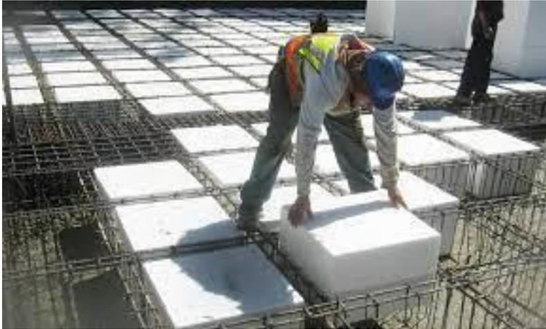
*Nota.* Aligeramiento de losa con bloques de icopor.
