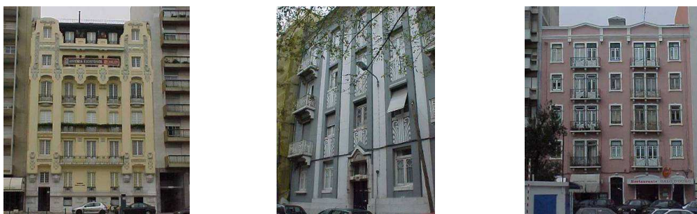
Figure 7 – Exemplos de edifícios gaioleiros.
