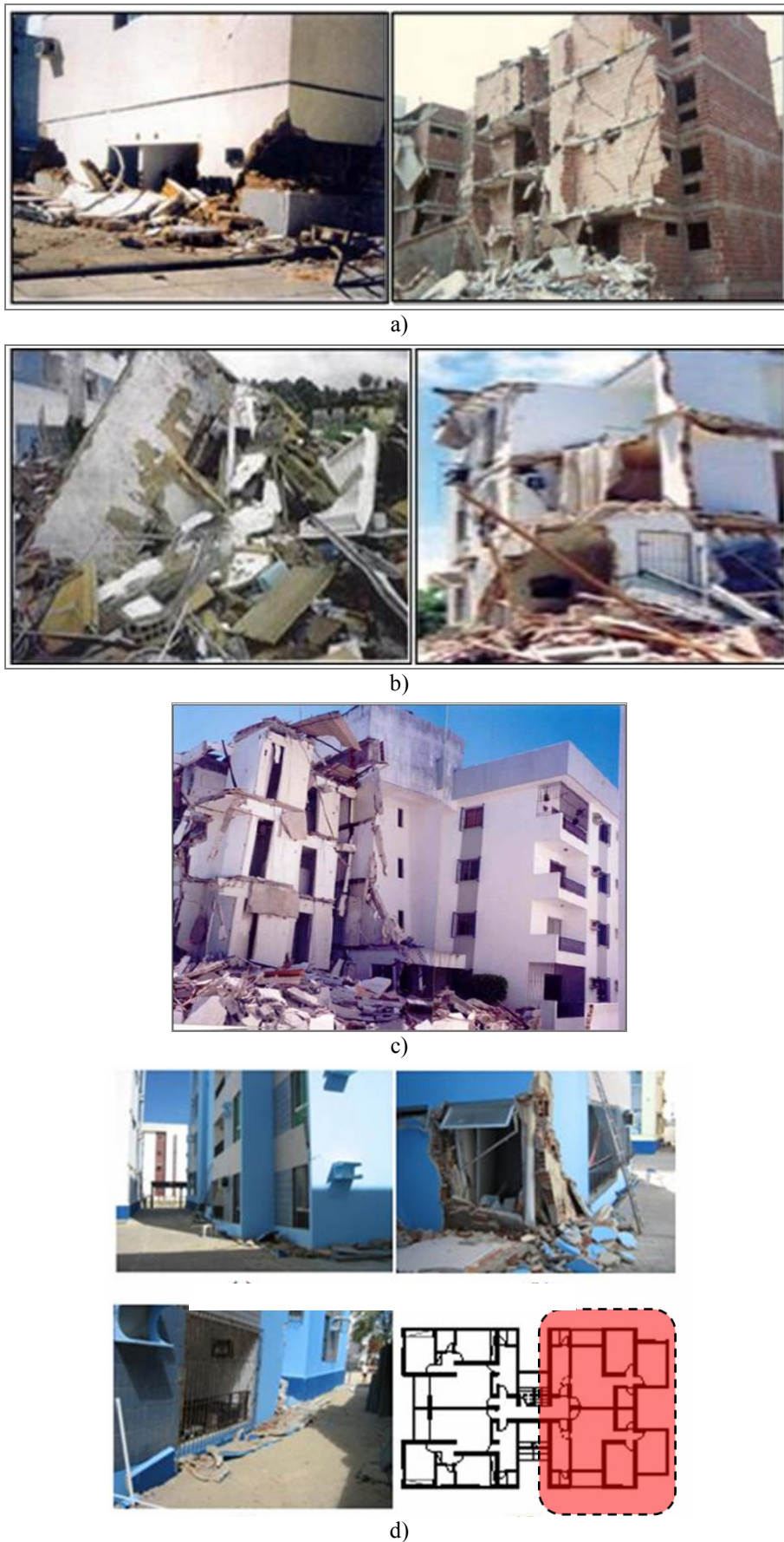
Figura 7: Acidentes em edifício-caixão em Recife: a) Jaboatão dos Guararapes e Recife; b) Olinda; c) Edifício Ijuí; d) Bloco B no Conjunto Residencial Sevilha
