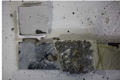
Figura 15 – Destacamento na interface adesivo/MDL para o provete M10F1S2T0_2.
