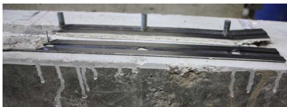
Figura 11 – Pormenor da rotura referente ao provete M8F3S1T0_2.
