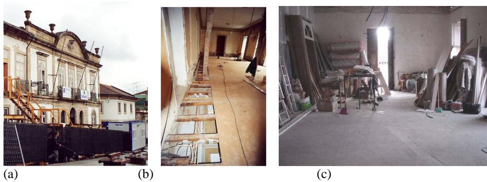
Figure 4: Plancher en étude: (a) vue de l'extérieur du bâtiment; (b) détail des poutrages et de la réhabilitation; (c) aspect du plancher à la fin de l'opération de réhabilitation
