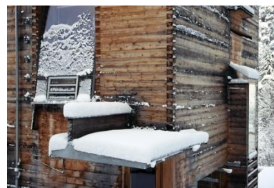
Figura 3 - Antonius Lanzinger. Tyrol, Austria. Casa de madeira de 4 pisos. A madeira assume funções estruturais e de fecho
