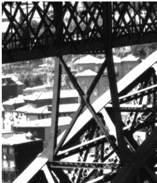
Figura 6 - “Pilar PP” entre o tabuleiro superior e o arco. Figura 7 - Apoio entre o tabuleiro superior e um pilar de alvenaria.
