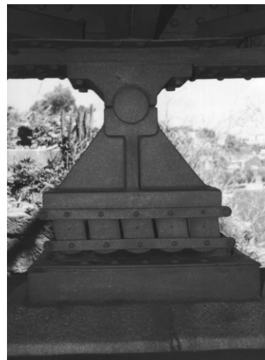
Figura 6 - “Pilar PP” entre o tabuleiro superior e o arco. Figura 7 - Apoio entre o tabuleiro superior e um pilar de alvenaria.
