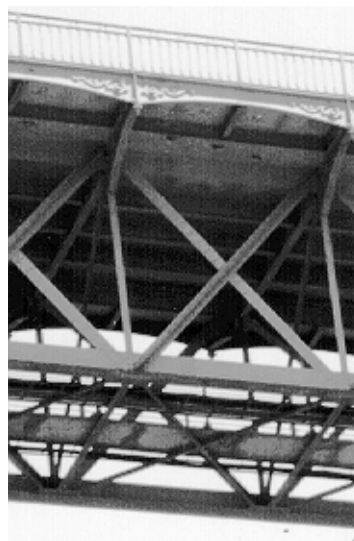
Figura 5 - Perspectiva de um módulo tipo do tabuleiro superior.
