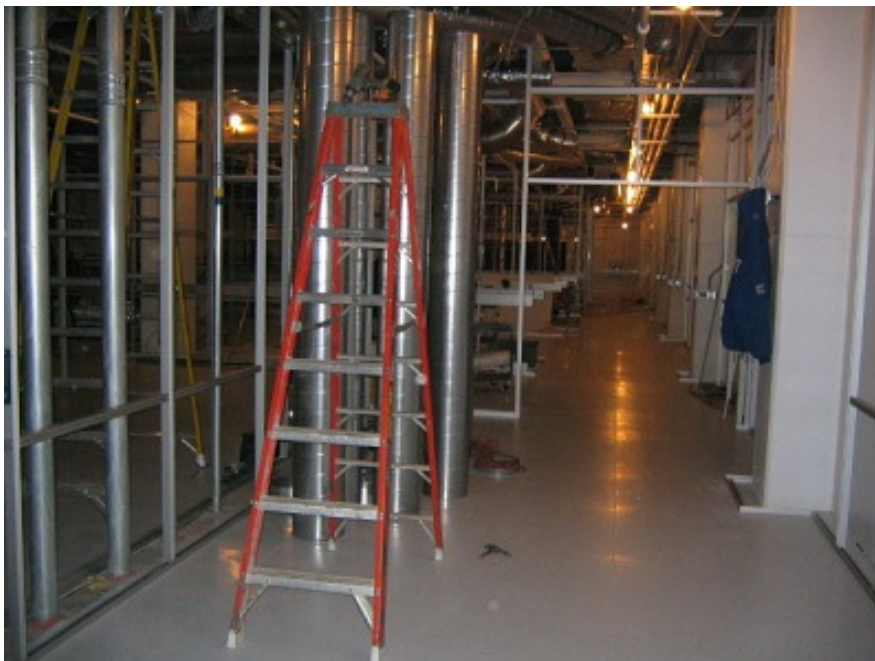
Figura 7.20.: Aspectos da montagem das divisórias interiores num laboratório de investigação 341 .
