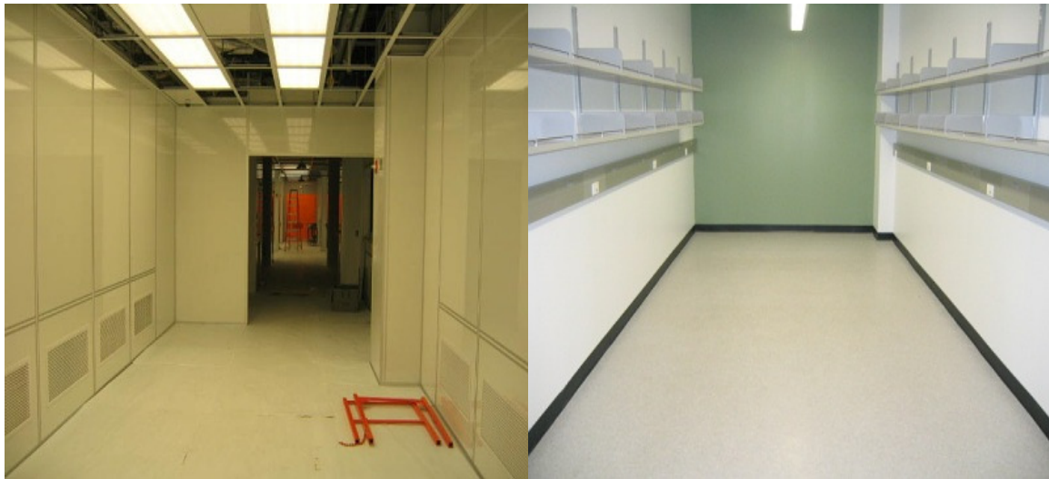
Figura 7.21.: Aspectos da montagem das divisórias interiores num laboratório de investigação. 342
