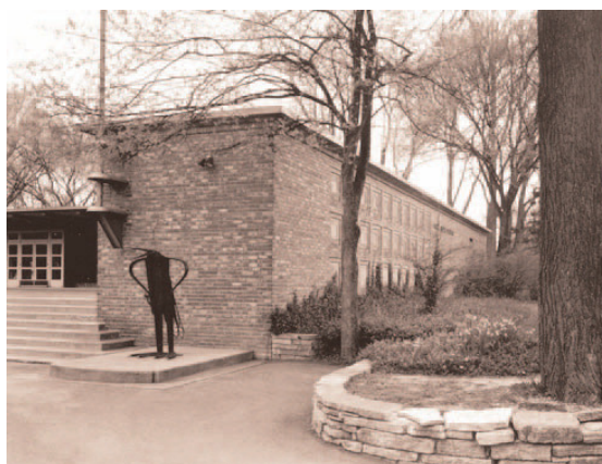
Figura 5.21.: A entrada principal de um edifício 153 .
