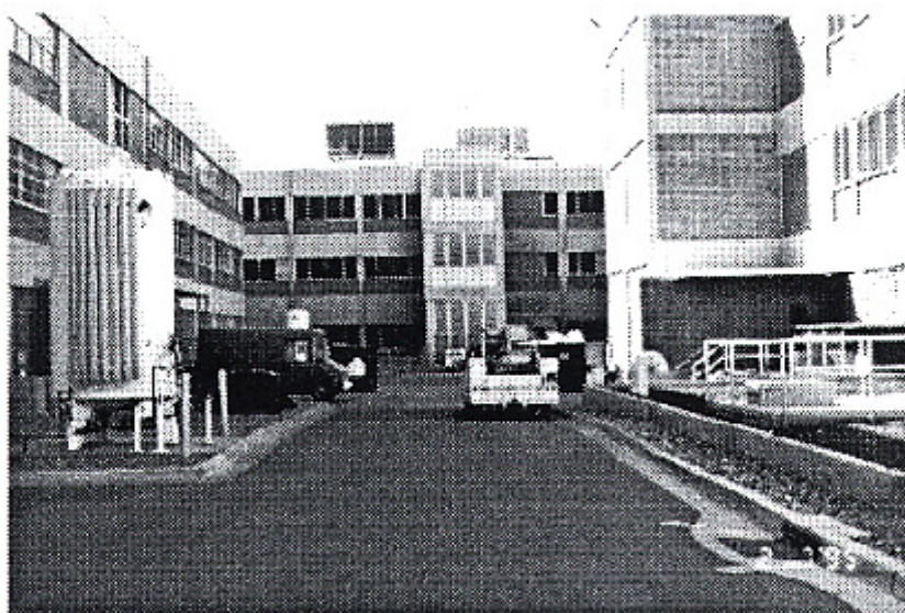
Figura 6.4.: Aspecto 173 de uma área exterior de serviços centralizada e partilhada entre edifícios vizinhos 174 .
