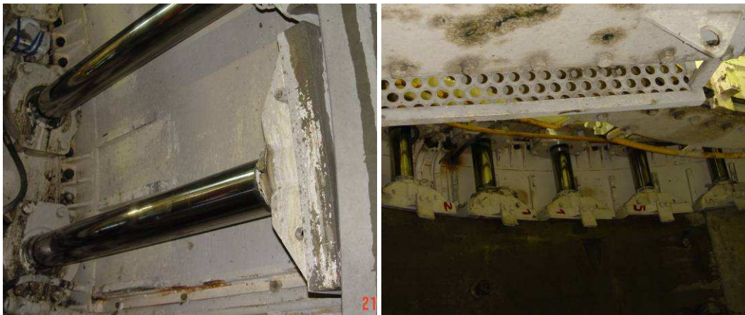
Figura 6 – Instalação pelo escudo
