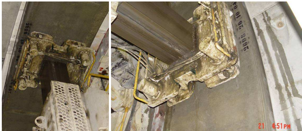
Figura 5 – Manipulação pelo erector
