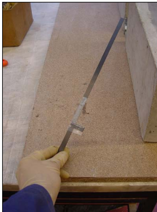
Figura 32 – Aplicação do adesivo no laminado.
