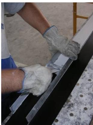
Figura 11. Aplicação de resina nos laminados
