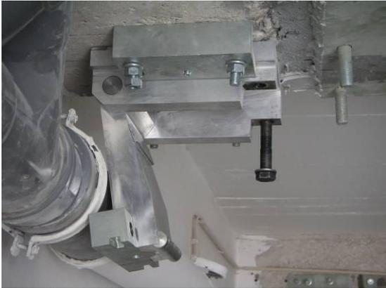
Figura 9. Ancoragem de laminados
