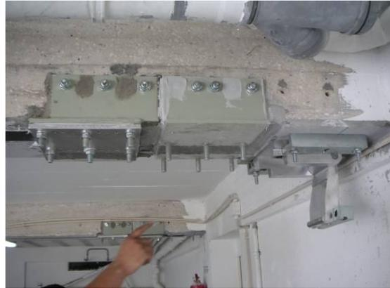
Figura 10. Adaptadores metálicos de ligação às vigas
