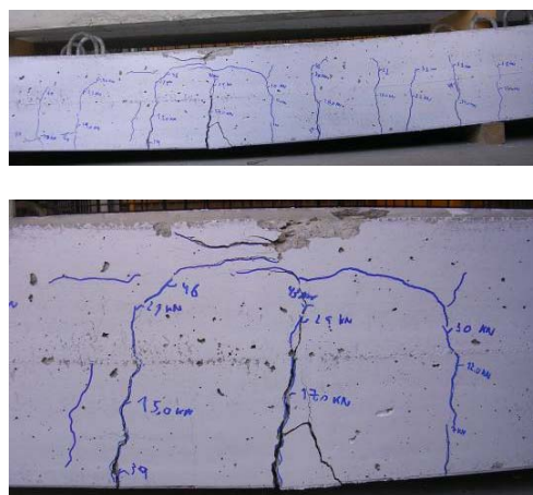
Figura 7. Modo de rotura da viga V00
