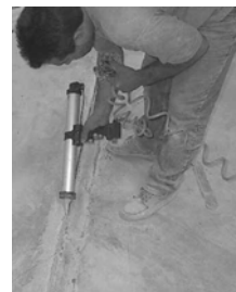
Figura 16. Aplicação do produto de selagem
