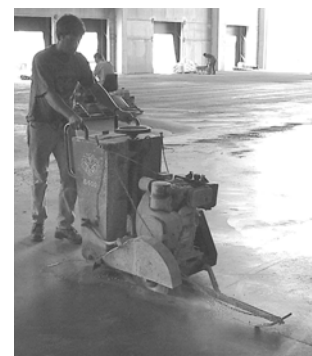
Figura 12. Realização de uma junta serrada
