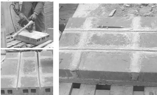
Figura 10. Realização de entalhes no betão.
