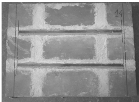
Figura 9. Elementos de casca reforçados com laminados colados na superfície do betão.
