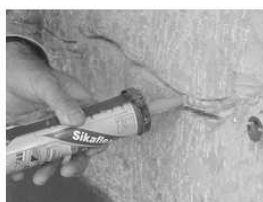
Figura 6: Tratamento das fissuras com mástique.
