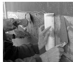
Figura 7: Revestimento armado com fibra de vidro
