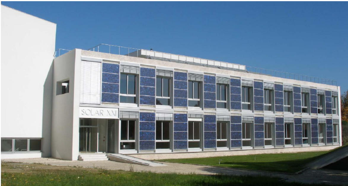
Figure 4.13. Edifício Solar XXI (INETI)
