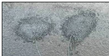
Figura 7.10: Termopares na camada de regularização e de desgaste
