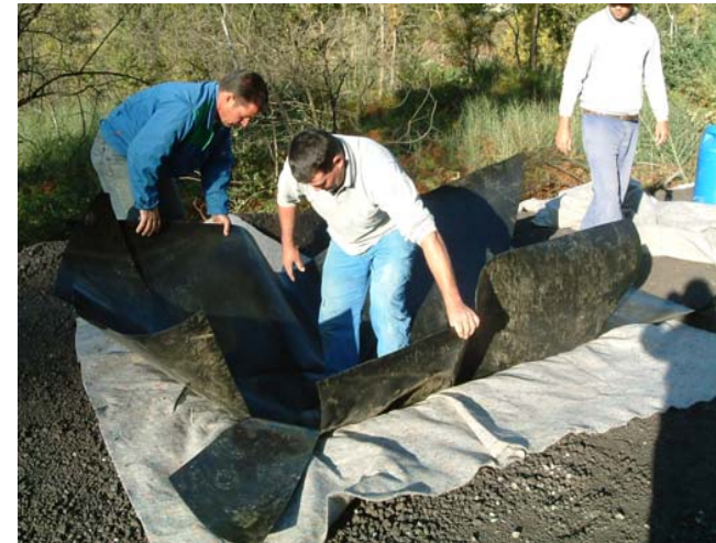
Colocação da geomembrana sobre o geotêxtil de protecção
