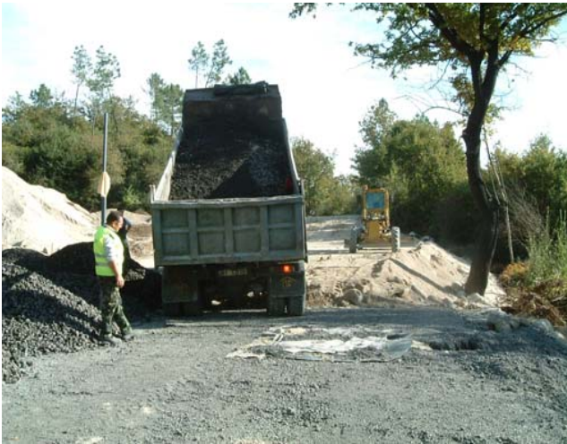
Colocação da camada de ASIC, a compactar sobre o lisímetro
