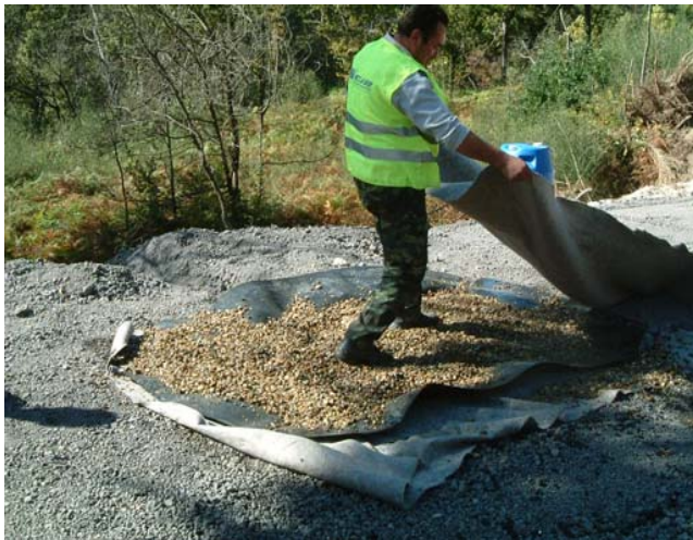
Colocação do geotêxtil de protecção ao seixo de preenchimento do lisímetro
