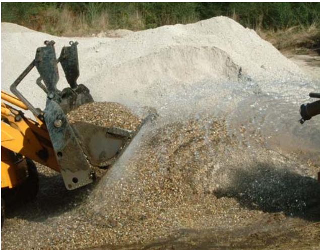
Lavagem do seixo de preenchimento do lisímetro
