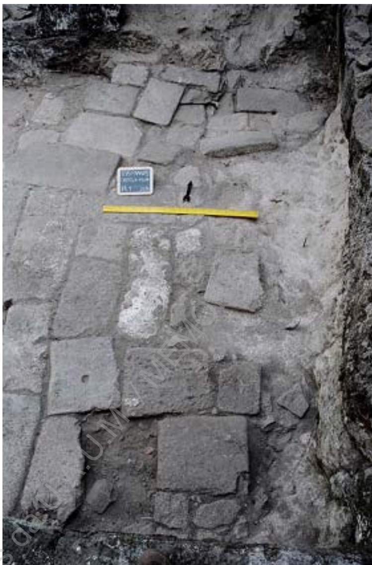
Foto 4 – Vista parcial da capela-mor, depois da limpeza (Plano 1).
