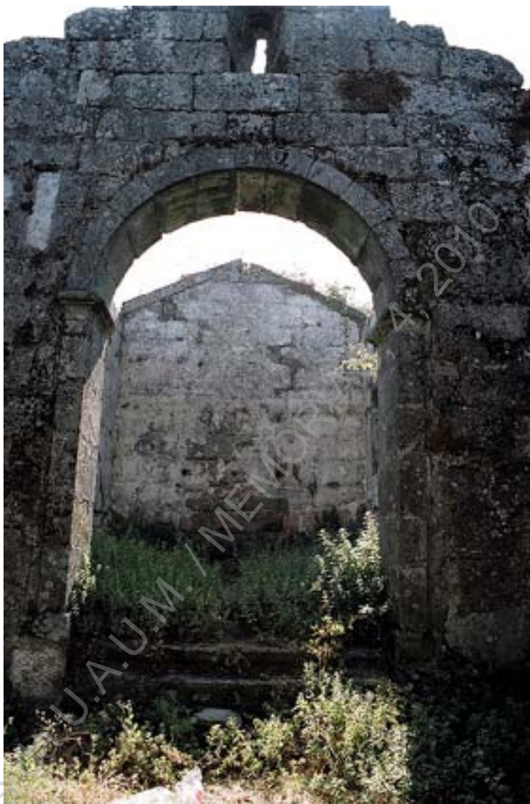
Foto 3 – Capela-mor, antes da intervenção.
