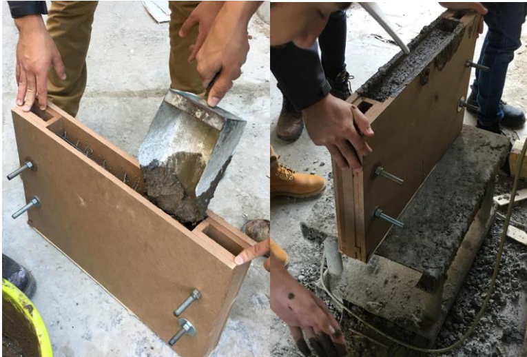
Fig. 11 Colocación mezcla en la cimbra
