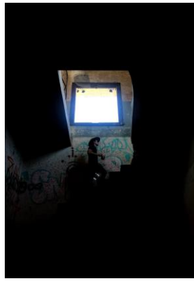
Fig.15 Vano sobre escalera
