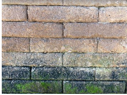
Fig.6 Enlamado del Block
