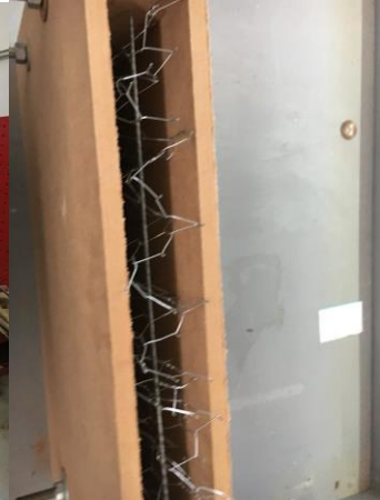
Fig. 5 Armado en cimbra
