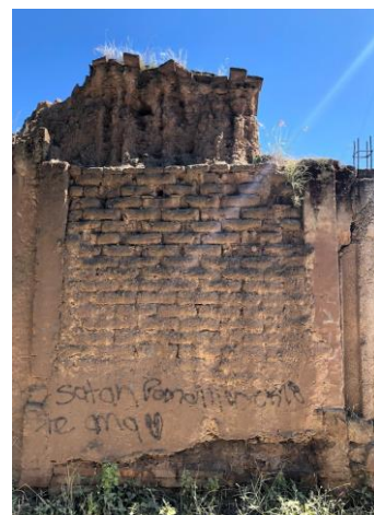
Fig.13 Muro de Adobe con intervenciones visibles
