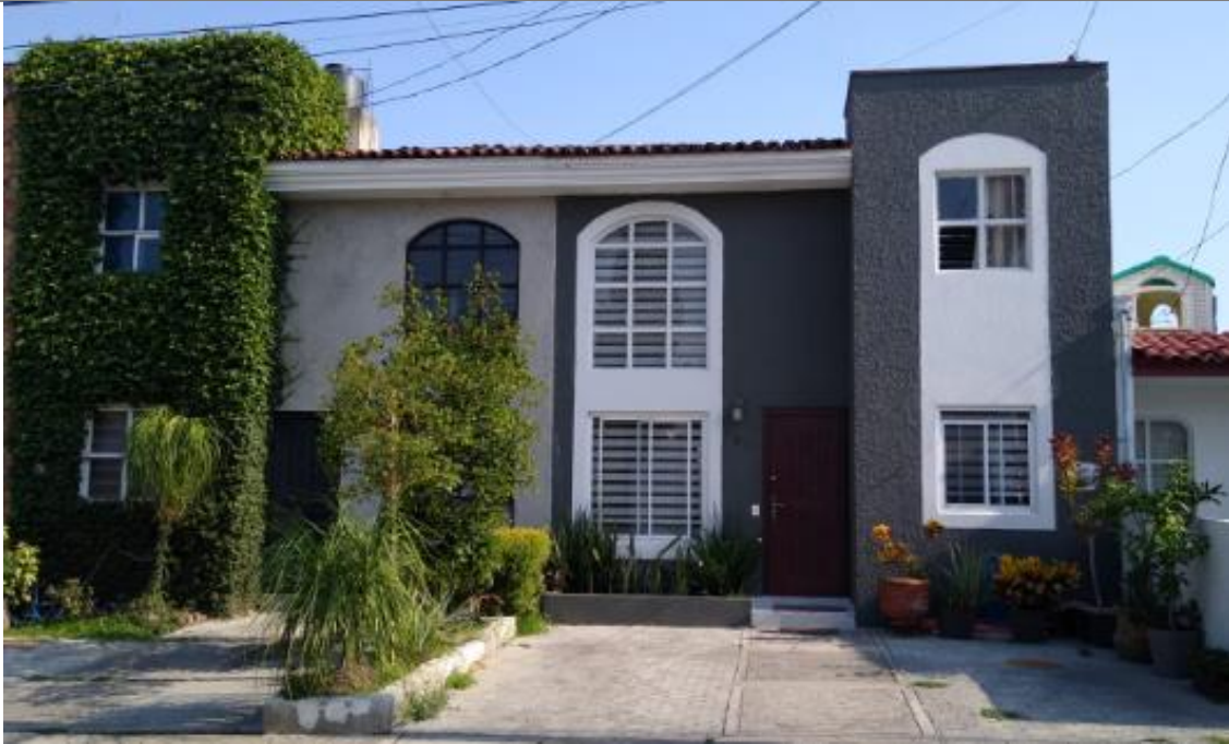
Figura 3.7 Fachada principal de la vivienda de estudio
