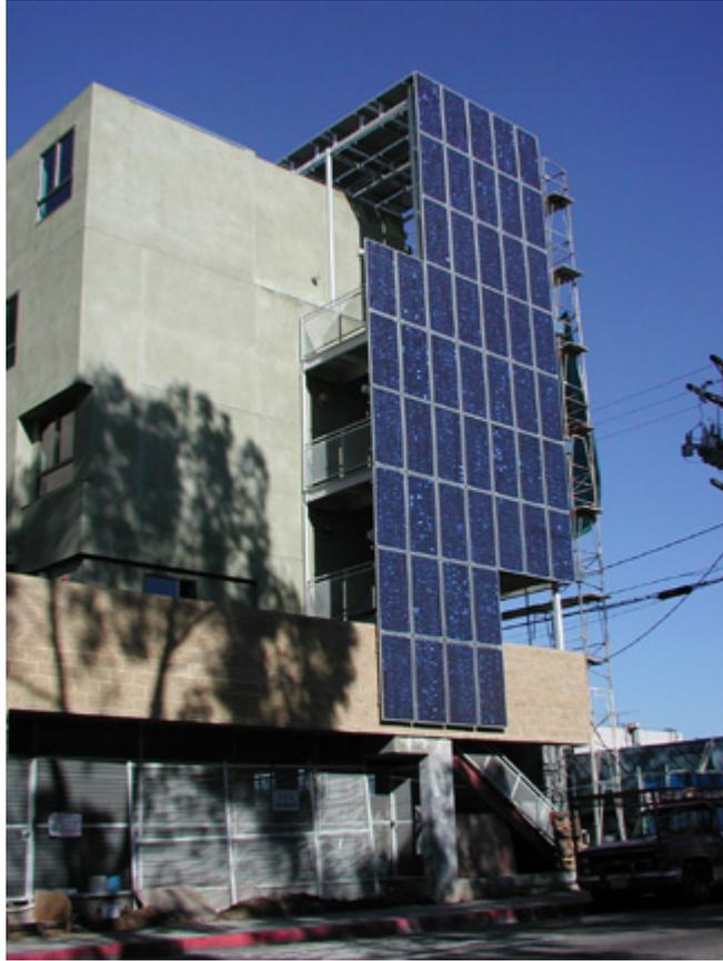
Figura 13: Painéis fotovoltaicos para produção de energia no COLORADO COURT
