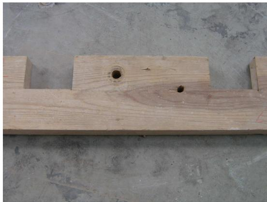
Figura 3.15 – Peças denteadas colocadas ao longo da face interior das empenas onde assentam as vigas do pavimento
