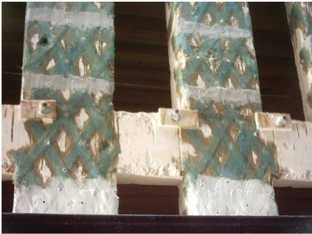
a) Vista das faixas de fibras de vidro coladas com resina epoxy
