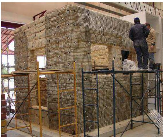
c) Aplicação da rede nas paredes do modelo
