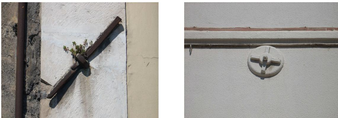
Figura 2.5 – Exemplos de peças metálicas de ligação
