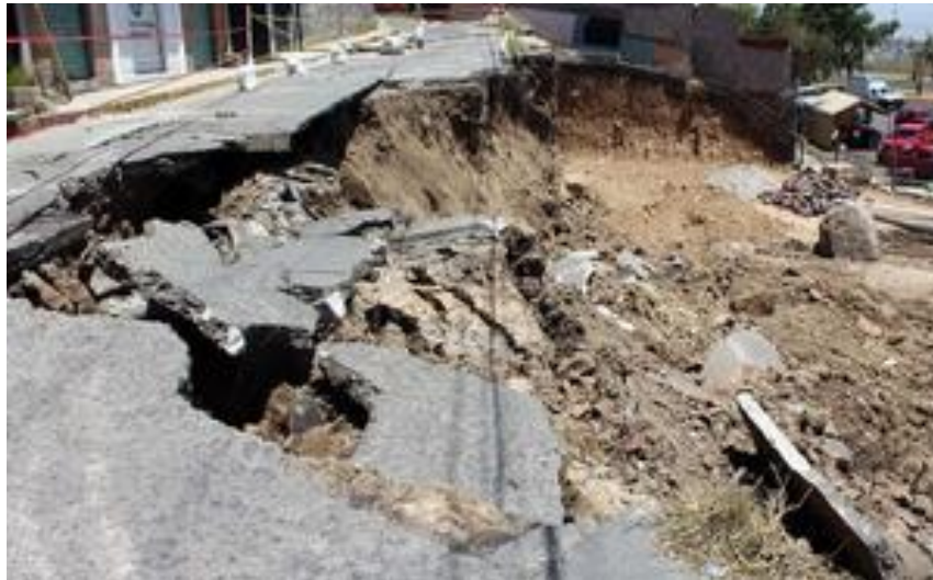
Figura 42. Derrumbes por descenso de los niveles freáticos (Milenio, 2017).
