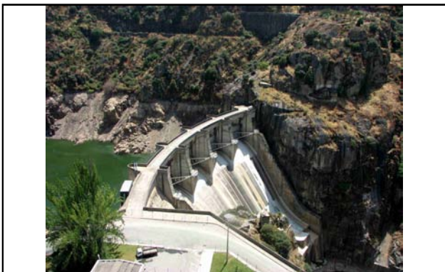
Vista geral sobre a barragem
