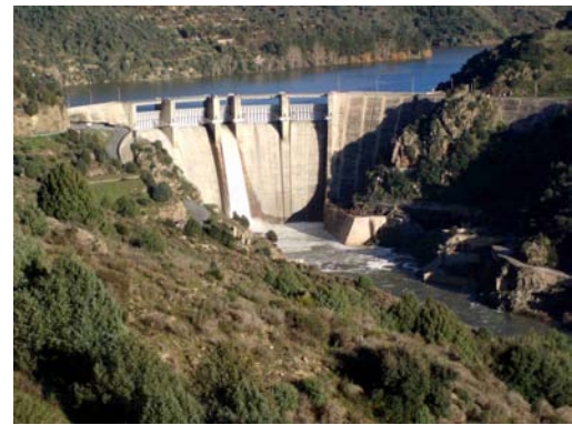
Barragem da Bemposta
