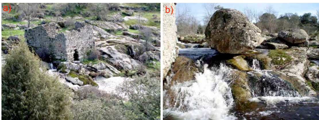
Figura 5.4 – Complexo moageiro de Quintanica: a) ruína de moinho em Quintanica; b) aspecto do vale pouco encaixado
