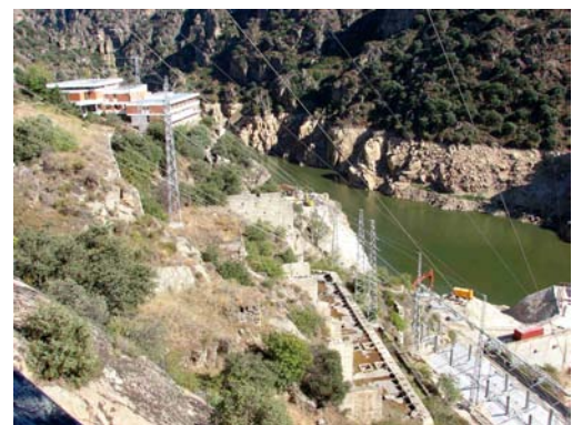
Intervenções humanas a montante da barragem
