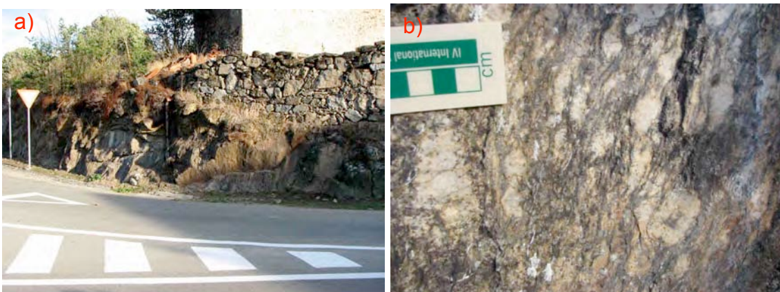
Figura 5.7 – Corte da rotunda junto à muralha de Miranda do Douro: a) aspecto geral do afloramento; b) aspectos estruturais e texturais do ortognaisse de Miranda
