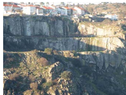
Vista geral sobre a pedreira
