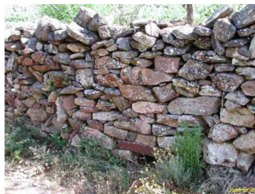
Aspecto actual do forno de cal
