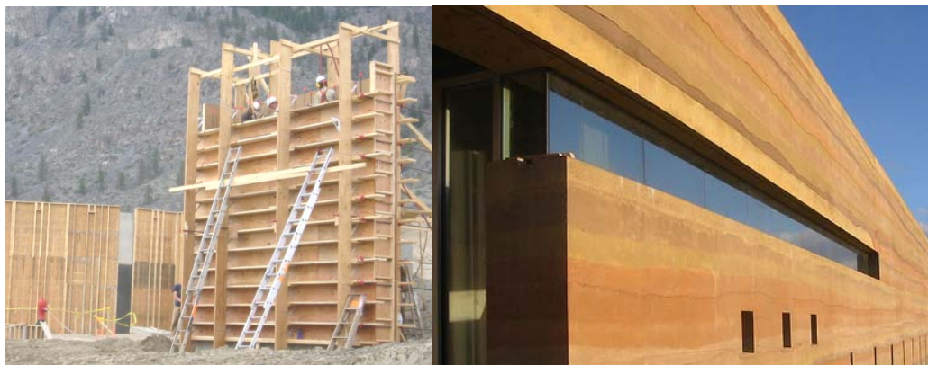
Figura 5 – Construção de parede e edifício em taipa
