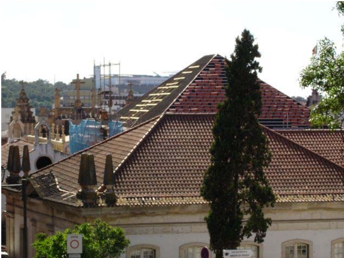
Figura 4 – Detalhes da execução; (a) cobertura existente em contacto com a abóbada fasquiada nas águas laterais, com apoios de nivelamento do telhado; (b) multiplicação de madres nas águas principais, com elevada deformação e reparações sucessivas; (c) aspecto da fendilhação e deformação da abóbada fasquiada; (d) aspecto da nova estrutura principal da cobertura; (e) aspecto de uma das asnas de canto; (f) madres e colocação do forro; (g) cobertura em fase de conclusão
