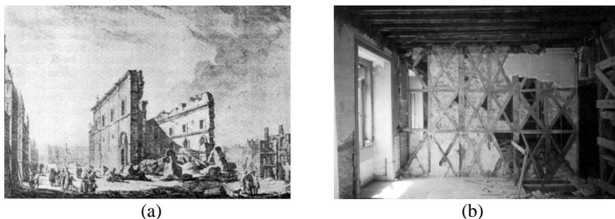
Figura 3 : Alvenaria “armada”: (a) imagem da destruição no terramoto de 1755; (b) o novo sistema compósito com paredes de alvenaria-madeira
