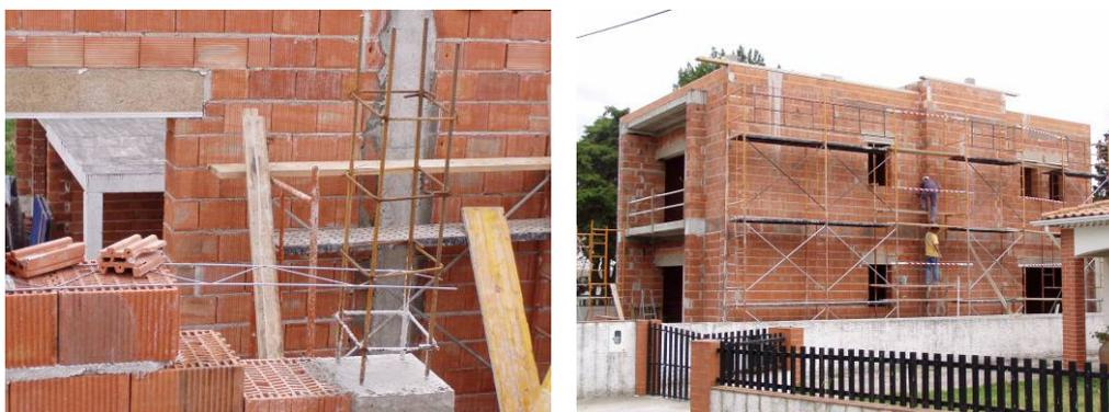
Figura 16 : Alvenaria moderna confinada com blocos cerâmicos de furação vertical: residência em Ílhavo. Fotografias gentilmente cedidas por F. Pagaimo.
