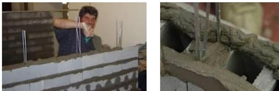
Figura 11 . Tecnologia de construção das paredes de alvenaria armada
