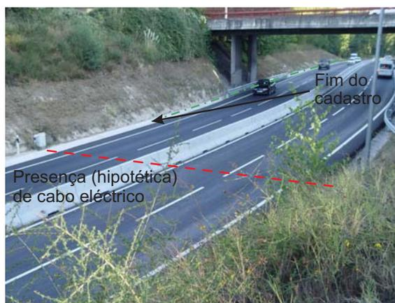
Figura 12 – Esquema dos ensaio de georadar para localizar o cabo eléctrico não cadastrado entre a caixa eléctrica e o poste de iluminação.
