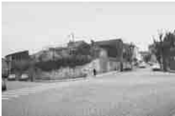
Figura 18 – Zona do Ex-Albergue Distrital em 1982, antes das obras previstas 31
