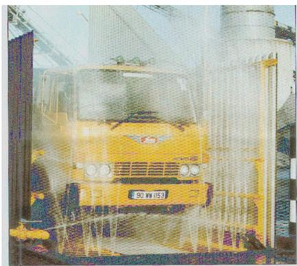
**Fig .3. Equipamento de lavagem à saída do estaleiro**
