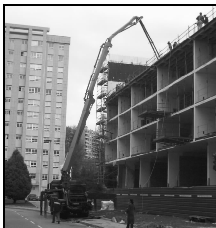
Figura 2 – Utilização de autobomba para betonagem de laje.
