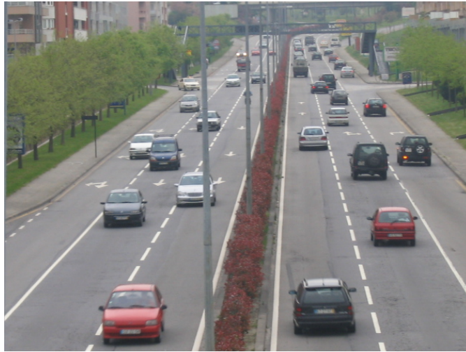
Foto 3 – Via urbana de elevada capacidade de tráfego
